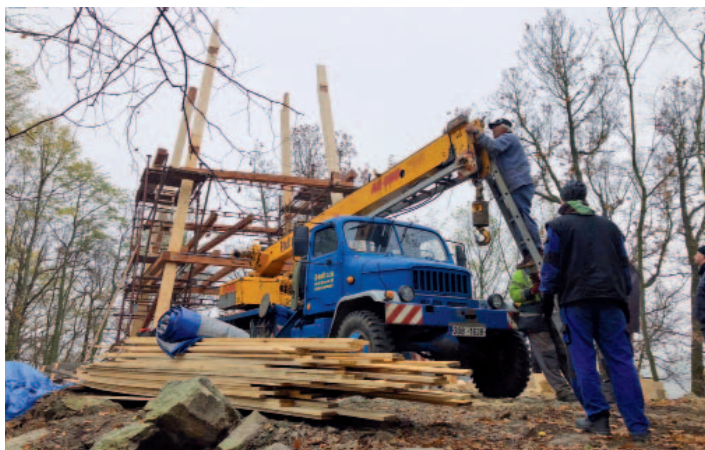
Umísťování prostředních částí nosných rohových trámů.
