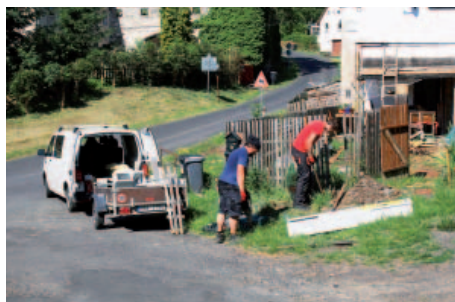
Práce na přenosu nadzemního elektrického vedení pod zem v Probošťově.
