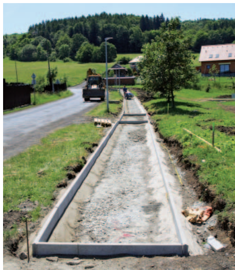
Budování chodníku nad hřištěm v Malečově.
