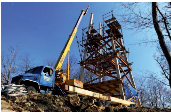
Osazování nejvyšších dílů nosných trámů.
