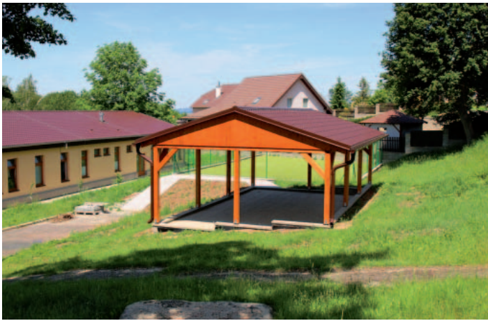
Nově vybudovaný přístřešek venkovní učebny základní školy.
