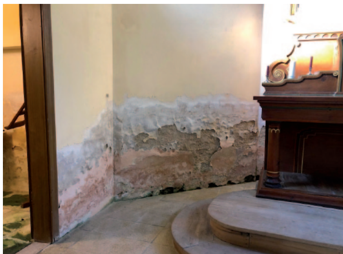
Snímky poškození interiéru kostela Panny Marie v Čeřeništi, které je způsobeno vztlínající vlhkostí.
