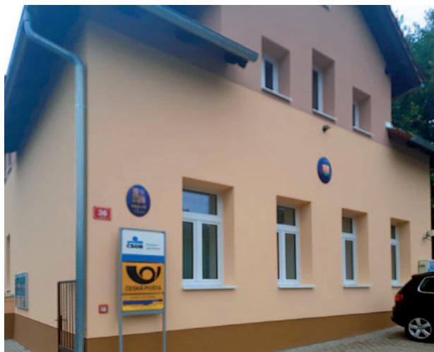
Rekonstruovaná fasáda budovy obecního úřadu.
